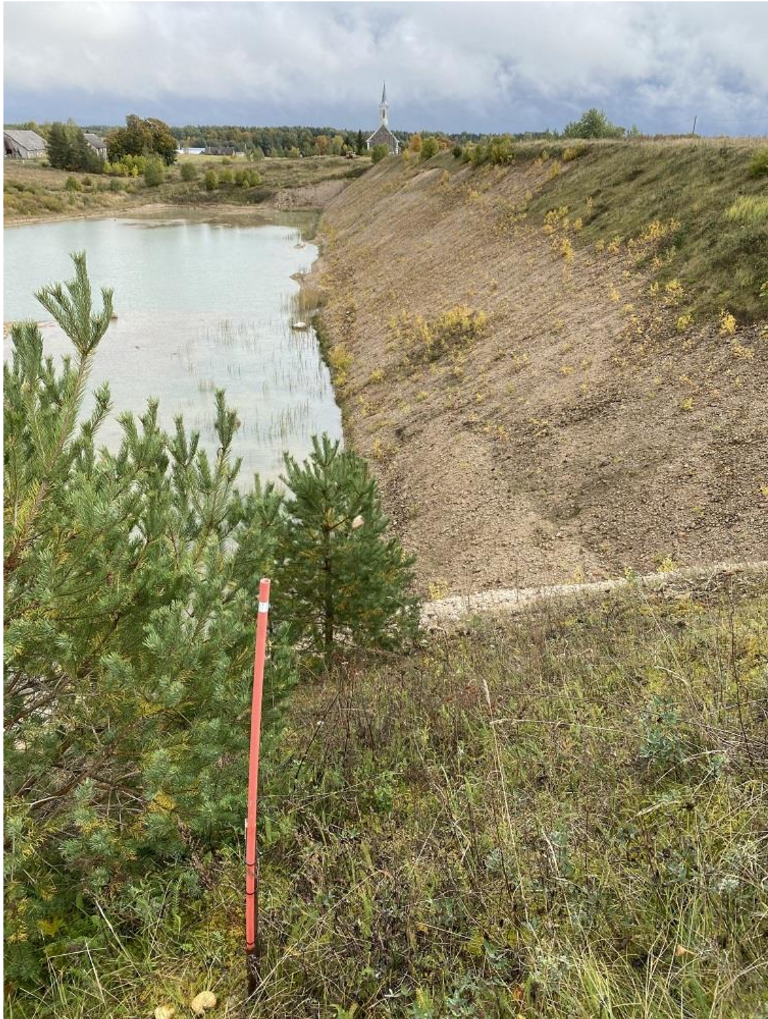
Joonis 2. Vaade korrastatava maa lõunaküljele. Esiplaanil nõlvus 1:1,7, tagaplaanil 1:1,4. Pildistamise aeg: 29.09.2022
